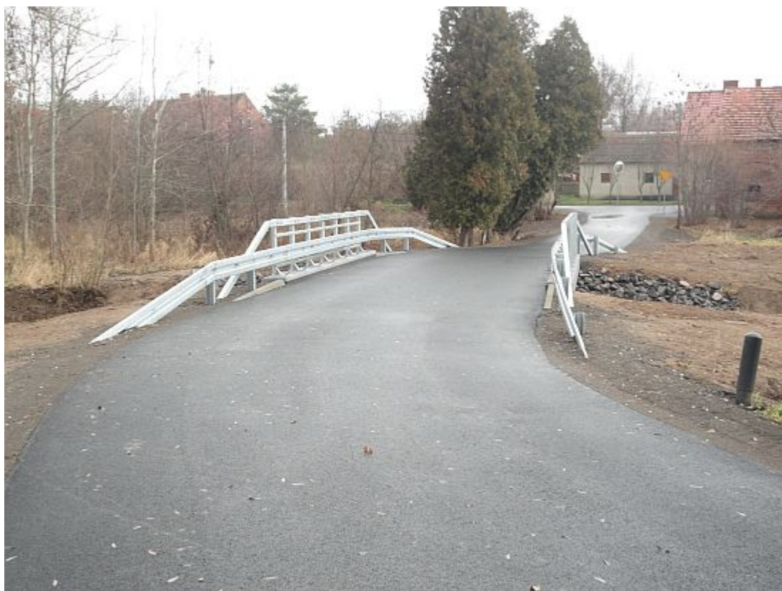
Przebudowy drogi w miejscowości Kościelnik:
